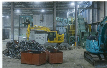
▲重機群が稼働する処理工場では1日350tの再資源化処理が可能。
